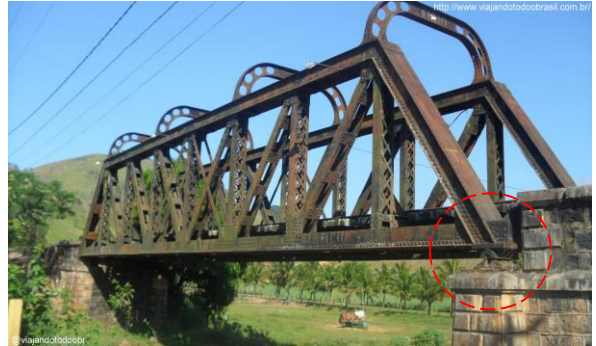
Um dos lados da ponte é móvel, para poder dilatar ou contrair.
