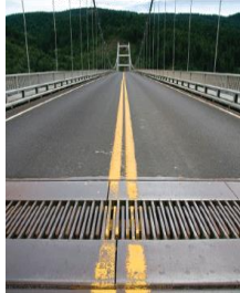
Juntas de dilatação de pontes, são usadas para acomodar as variações do tamanho da ponte devido a variação de temperatura.
