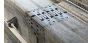
Juntas de acomodação térmica.
